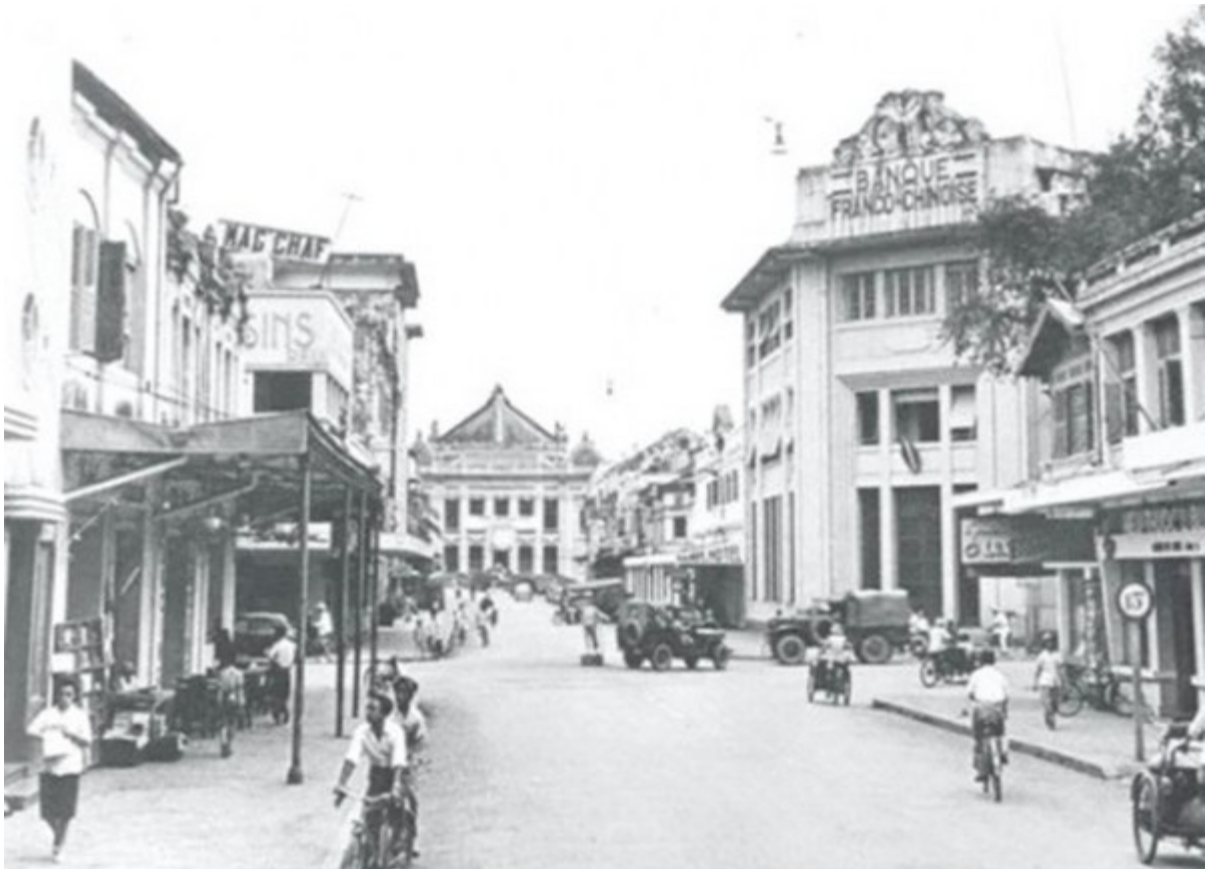
Đường phố Hà Nội, hình chụp vào tháng 7 năm 1954.
